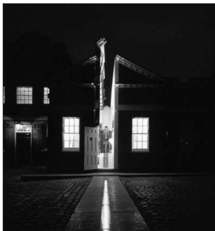
**Figura 2** — Na imagem é possível ver o edifício que alberga o principal telescópio de trânsito circular do antigo observatório de Greenwich. Repare-se que o telhado do edifício foi recolhido por forma a deixar uma estreita faixa de observação, a qual está alinhada com a linha *meridiana imaginária*, representada por uma guia metálica no solo, visível até à porta do edifício e à base do telescópio. Reprodução da capa do livro *Greenwich Time and the Longitude*. Howse, Derek, NMM (UK), 1980.
