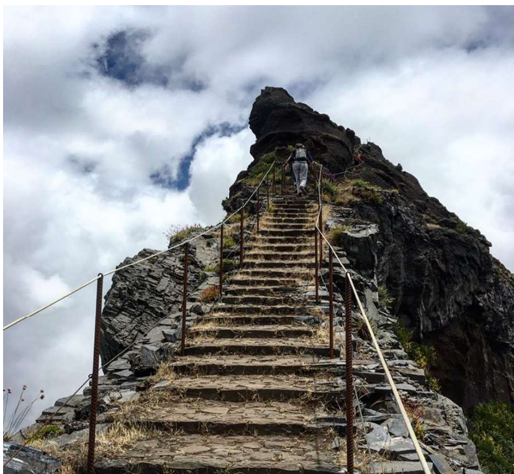
Foto 13 – Apesar de estarem «na moda», não devemos optar pela construção destes passadiços (P. Góis).
