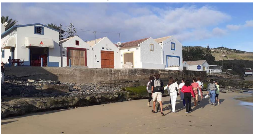
Foto 5 – Alunos de turismo observam as consequências da subida do nível médio das águas do mar nas dunas e nas casas da lancha. (Saída de Campo à Praia do Porto Santo).
